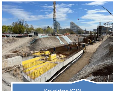
Kolektor IGIN zaklonišče, podhod, SV naprave
