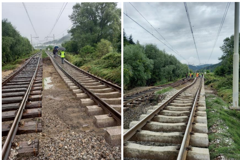
Slika 4: km 531+770, v nasprotni smeri stacionaže, levi tir, betonski pragi – tirnice 60E1, desni tir, leseni pragi – tirnice 49 E1
