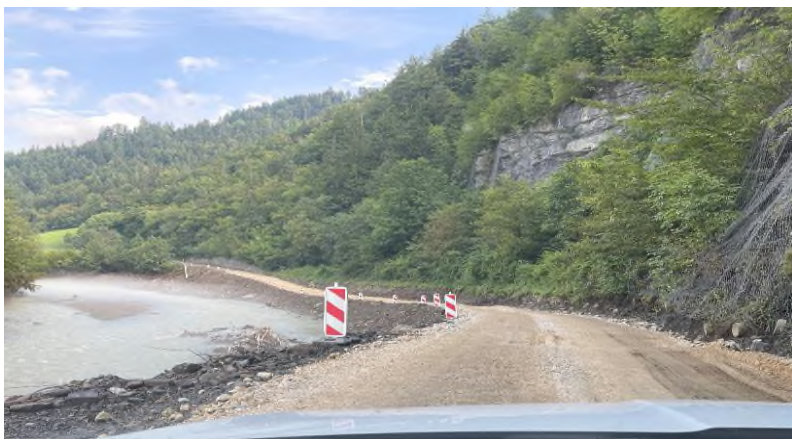
Slika 2: Izvedba začasne vzpostavitve prevoznosti
