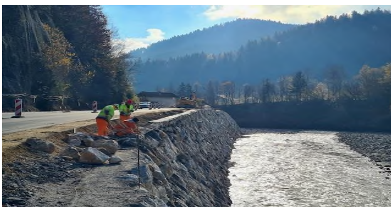
Slika 3: Izdelava podpornega zidu
