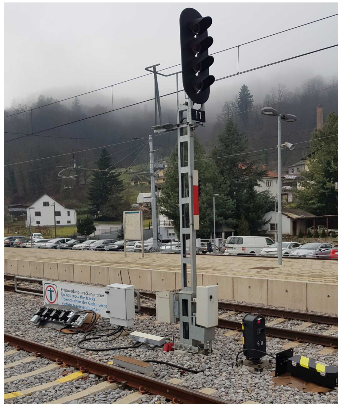
Montaža zunanjih SV naprav na postaji Poljčane
