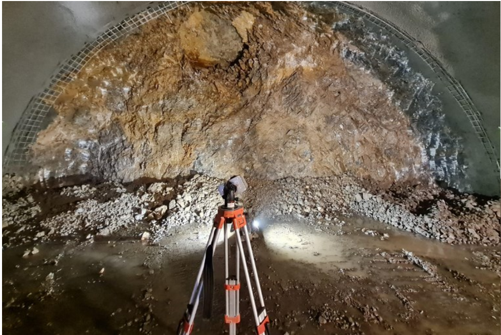
Fotogrametrični zajem in izdelava 3D modela izkopnega čela
