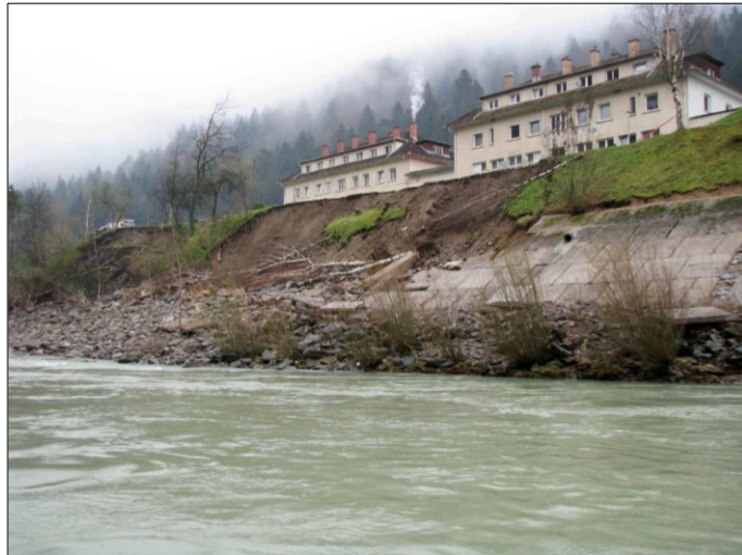
Usad brežine in porušena obloga ogrožata cesto (Foto: arhiv ZAG)
