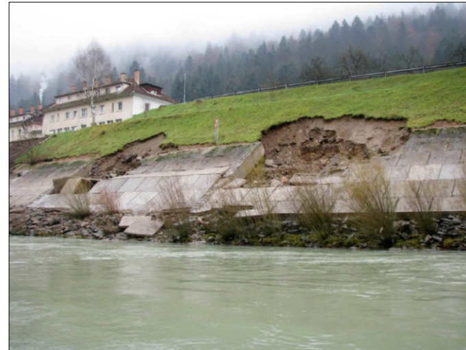
Usad brežine in porušena obloga ogrožata cesto (Foto: arhiv ZAG)
