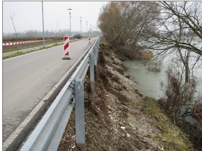
Poseden in razpokan nasip ceste, erodirana brežina (Foto: arhiv ZAG)
