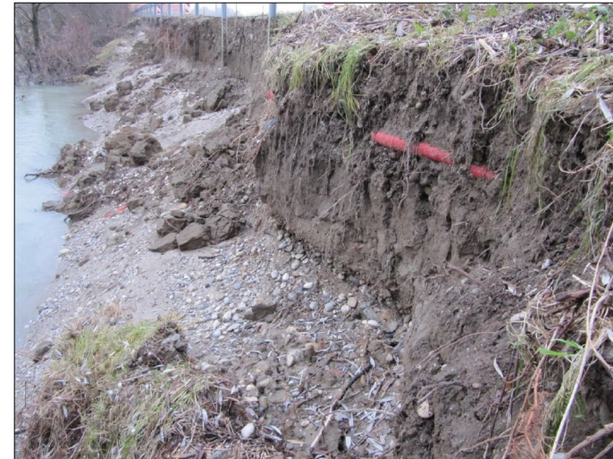
Poseden in razpokan nasip ceste, erodirana brežina (Foto: arhiv ZAG)
