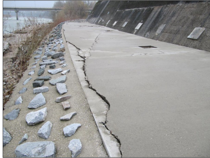
Poškodbe betonskega vozišča pri jezu Melje (Foto: arhiv ZAG)
