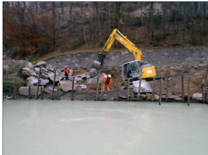
Sanacijska dela na usadu, ki je poškodoval cesto (Foto: arhiv ZAG)
