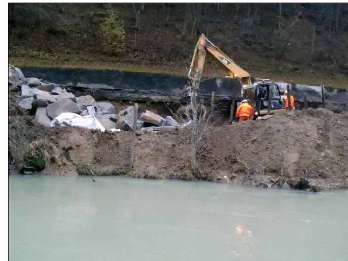
Sanacijska dela na usadu, ki je poškodoval cesto (Foto: arhiv ZAG)
