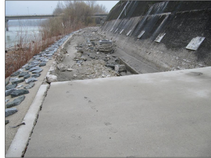
Poškodbe betonskega vozišča pri jezu Melje (Foto: arhiv ZAG)
