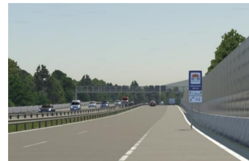
SPS portal na prvotni lokaciji
