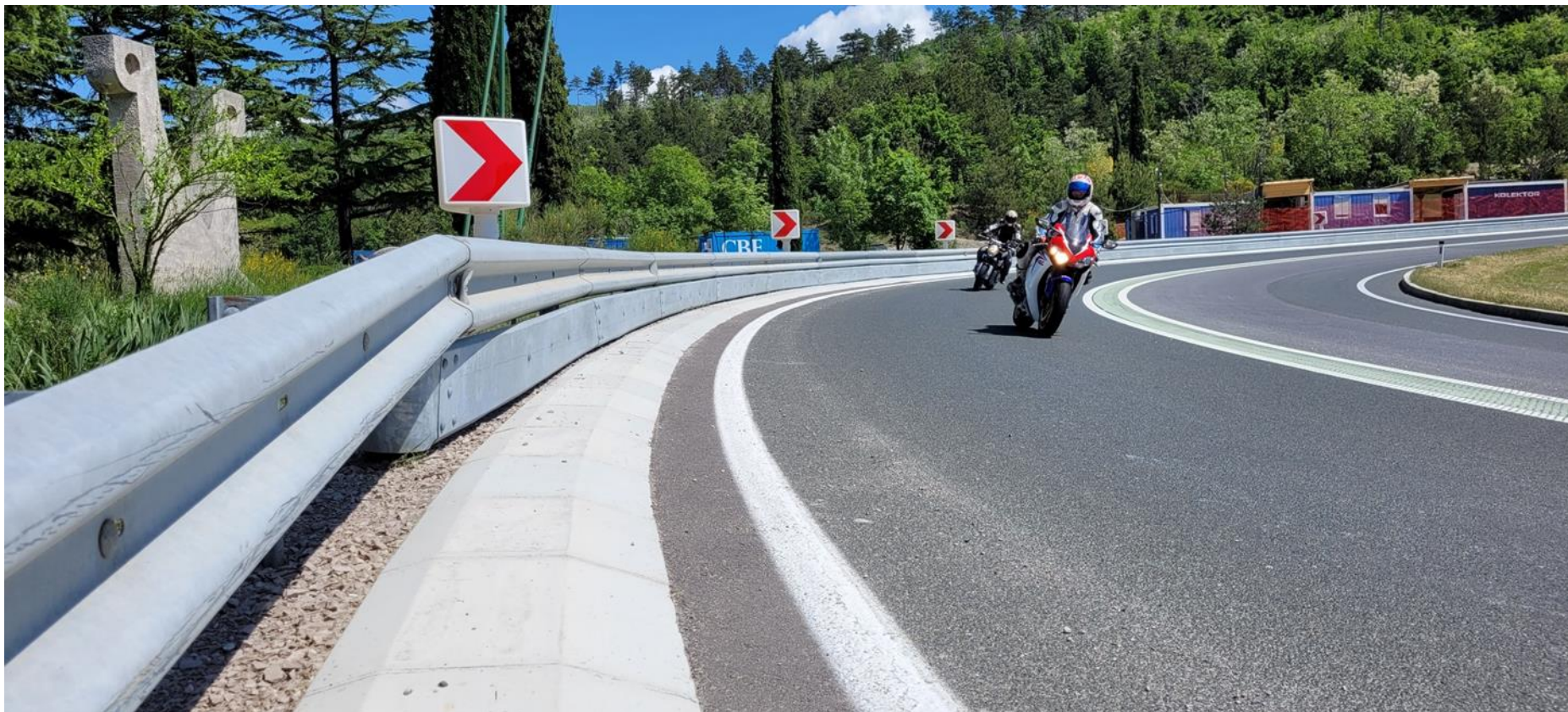
Izvedba robnika na način, da ne poškoduje motorista
