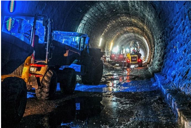
Dela v železniškem predoru Karavanke | Avtor Miško Kranjec
