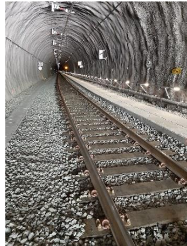
Nadgrajen železniški predor Karavanke | Avtor DRSI
