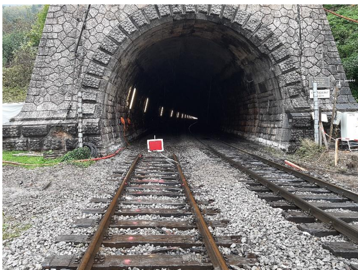
Odstranjen tir 2 v predoru | Avtor Direkcija za infrastrukturo
